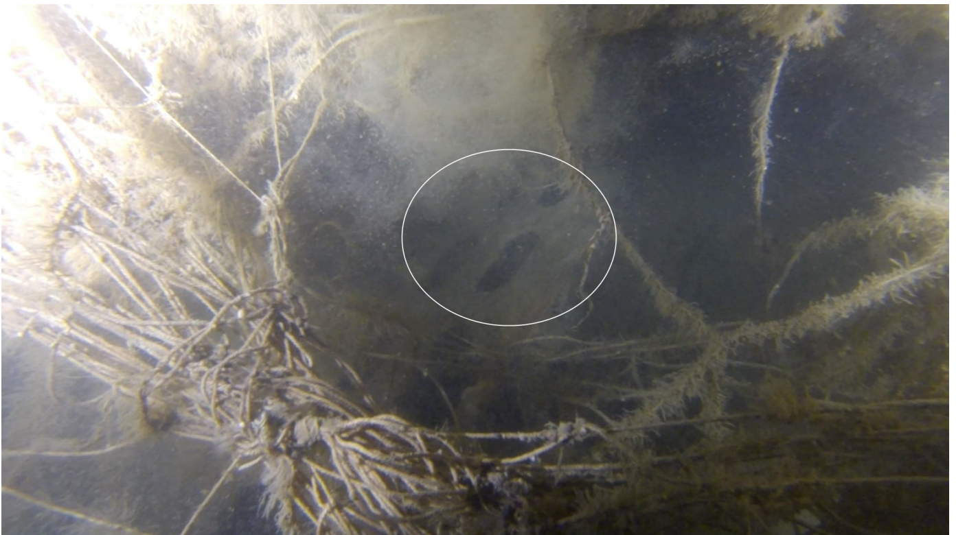
Niesparowane otwory przelewowe pod kioskiem (Lewa Burta).
